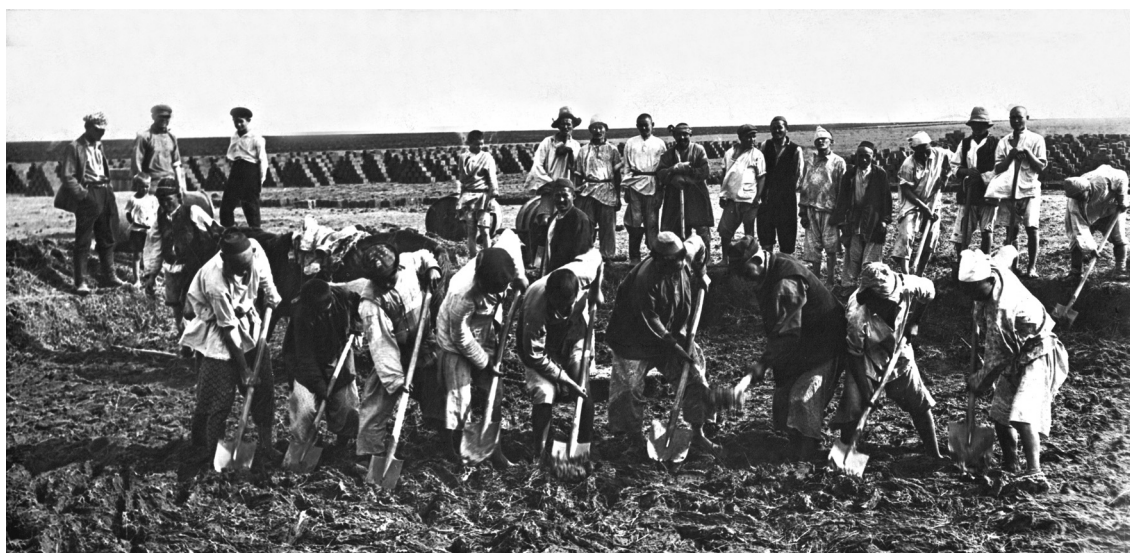
Рис. 5. Смешивание глины с соломой для получения самана (1-я треть XX в.). Фотоархив Омского государственного историко-краеведческого музея. Оригинал
