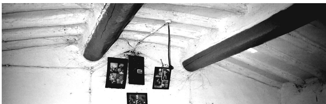
Рис. 11. Устройство крыши в саманном доме. Немцы (1-я треть XX в.). Фотоархив МАЭ ОмГУ. Фрагмент оригинала
