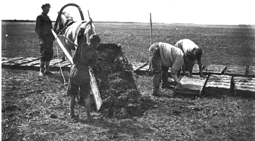
Рис. 7. Формовка саманных блоков (1-я треть XX в.). Фотоархив Омского государственного историко-краеведческого музея. Оригинал
