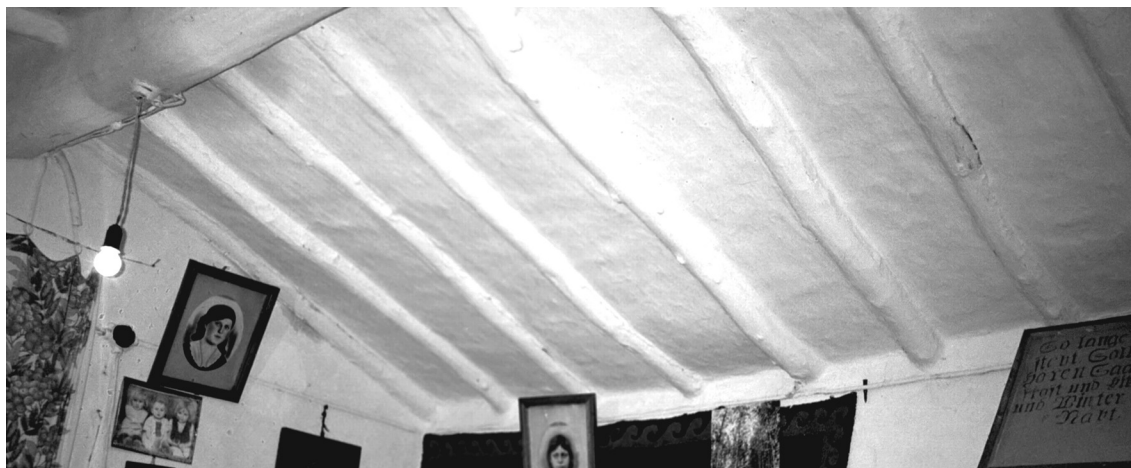
Рис. 10. Устройство крыши в саманном доме. Немцы (1-я треть XX в.). Фотоархив МАЭ ОмГУ. Фрагмент оригинала
