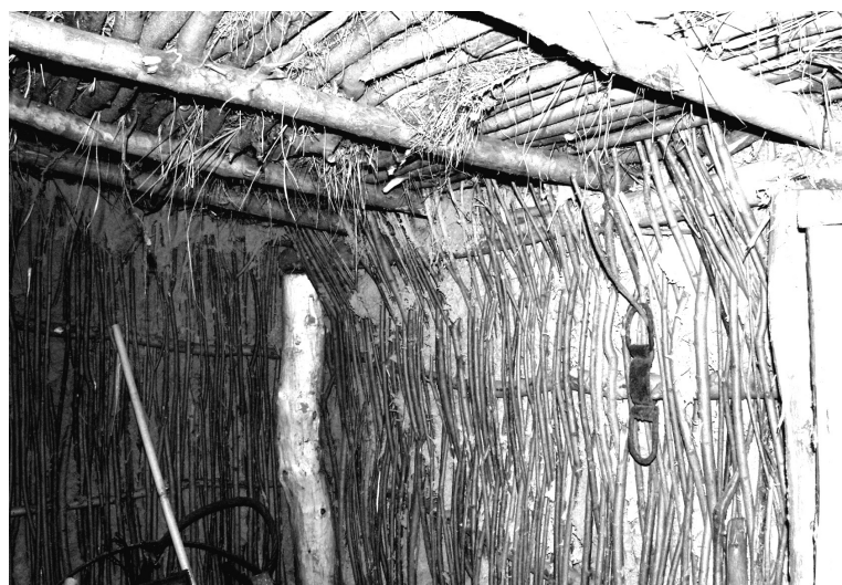
Рис. 3. Стена из плетеного каркаса, обмазанного глиной. Реконструкция. Украинцы. Кулунда. Петропавловский краеведческий музей (Краснозерский р-н Новосибирской области). Фото автора
