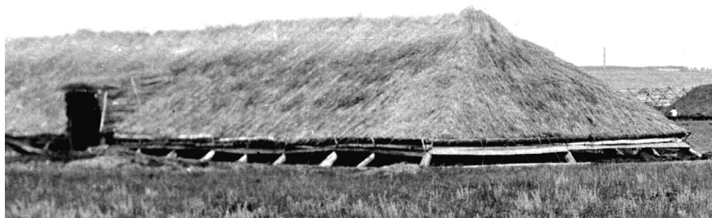
Рис. 9. Сарай для сушки саманных блоков и кирпичей (1-я треть XX в.).
