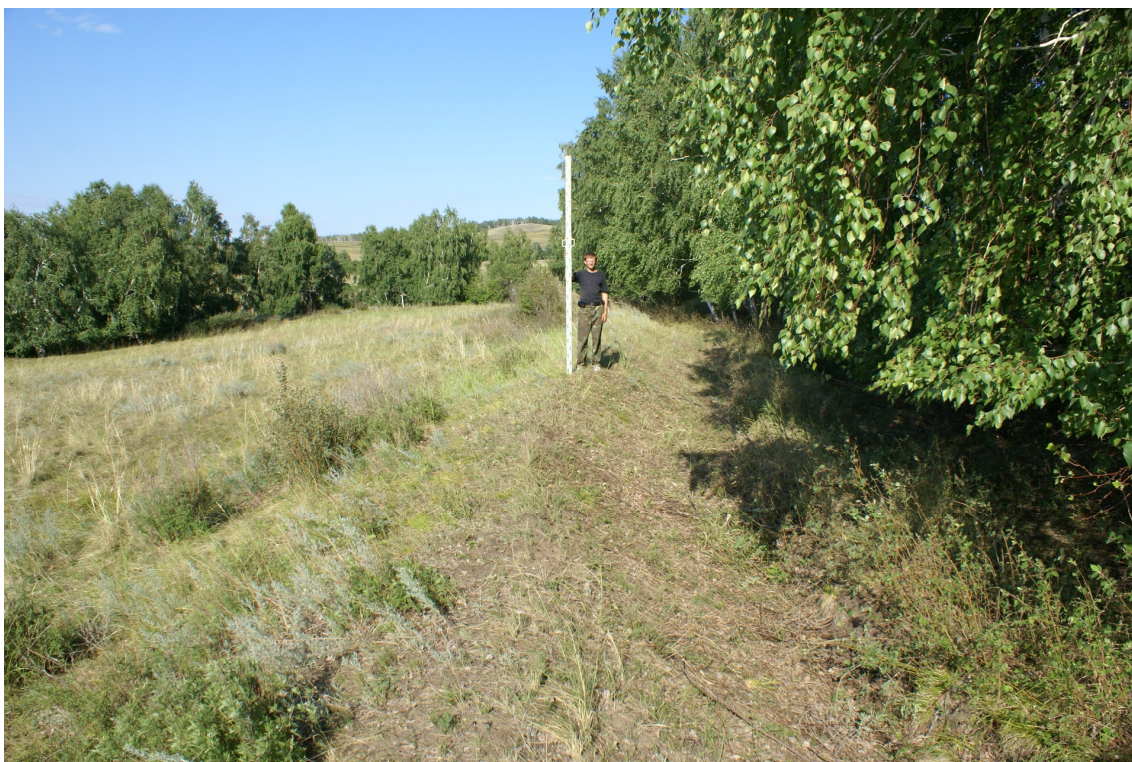
Рис. 6. (фото) Первичный осмотр участка вала и рва на горе Унюк в Краснотуранском районе Красноярского края
